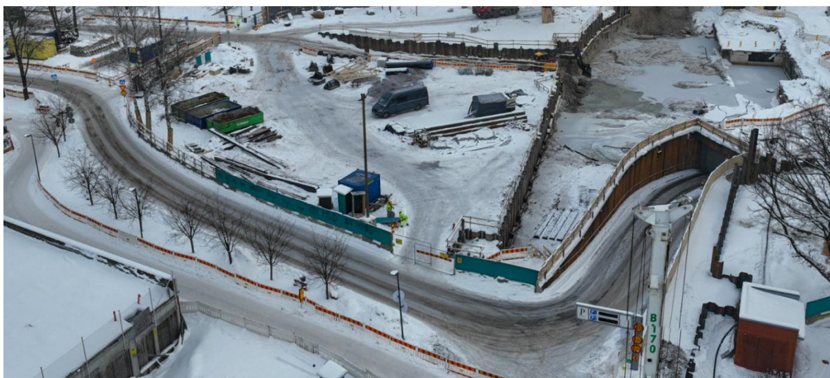
Kuva: Tikkuparkin ajoluiska Kirjastopuistossa Vantaan ratikan työmaan vieressä
